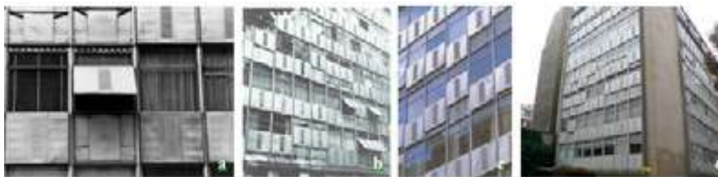
Figura 08: Prédio residencial - Square Mozart - Paris, 1953-54. Painéis seguindo o complexo sistema de janela guilhotina, com painel/veneziana deslizante até a altura do peitoril, permitindo controlar a luminosidade e a ventilação. a e b) Fachada original. c) e d) Fachada atual. A possibilidade de substituição dos painéis demonstra a flexibilidade da proposta de Prouvè de 1954, e a preservação de sua funcionalidade nos dias atuais.
