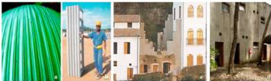
Figura 11: Sequência de imagens sobre o desenvolvimento das paredes estabilizadoras na Ladeira da Misericórdia, Salvador-BA. a) Folha de capim-palmeira. b) Detalhe das placas nervuradas em argamassa armada. c) Operário segurando uma placa plissada pronta. d) e e) Paredes de estabilização na Ladeira da Misericórdia.
