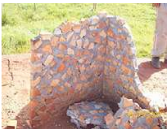
Figura 07: protótipo da parede plissada na residência Las Anitas (2006-08).
