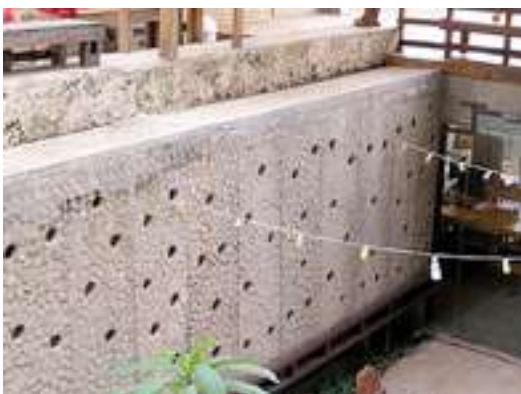
Figura 10: à esquerda, placas pré-fabricadas que separam pátio e cozinha na residência RP (atual sede de escritórios diversos) (2008); à direita, painéis plissados que vedam o volume superior da mesma casa
