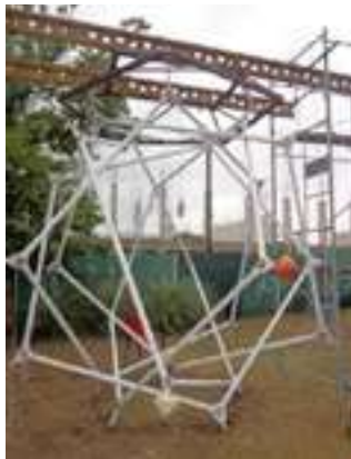
Figura 14. Proceso de montaje. Estructura auxiliar.
