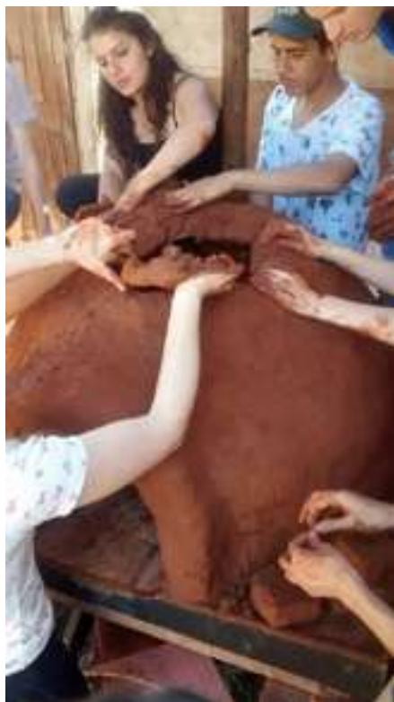
Figura 1: execução do forno de adobe na disciplina de Canteiro Experimental, barreamento
