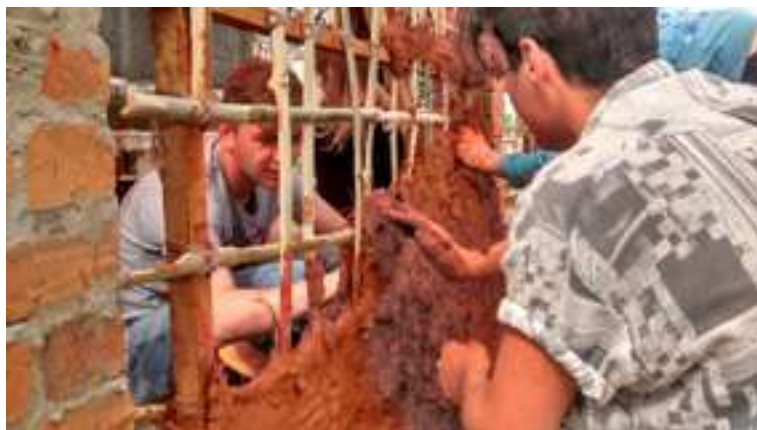
Figura 1: execução das taipas na disciplina de Canteiro Experimental, barreamento.
