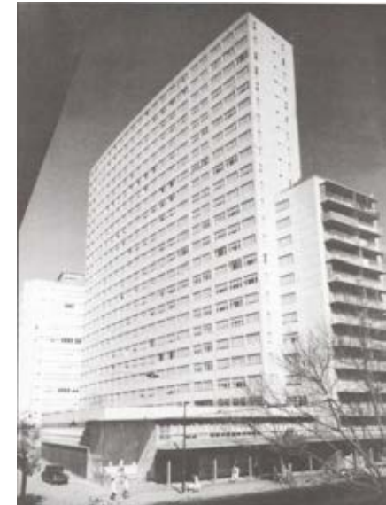
> Edificio Nicolas Repetto / Conjunto Hogar Obrero. Caballito
