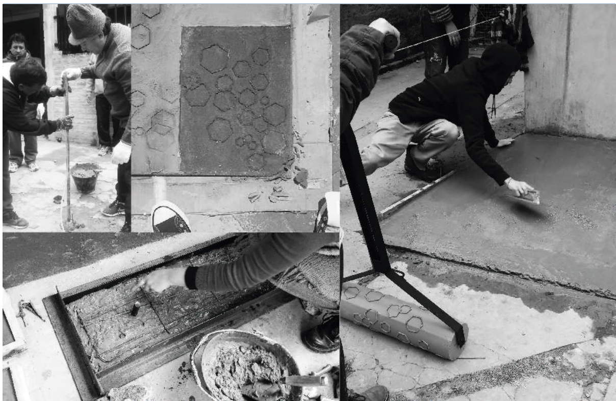
IMÁGEN 4. CONSTRUCCIÓN. PROYECTO VILLA 15. FOTOGRAFÍAS PROPIAS.
