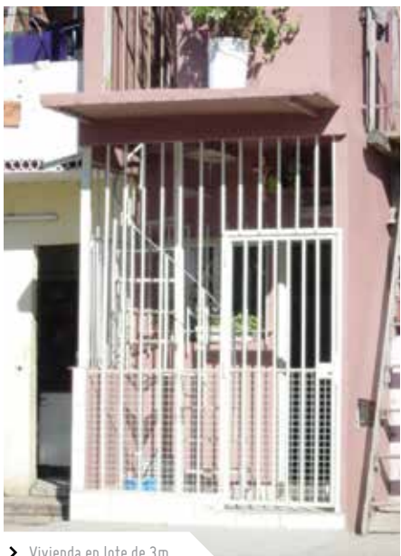
➤ Vivienda en lote de 3m
