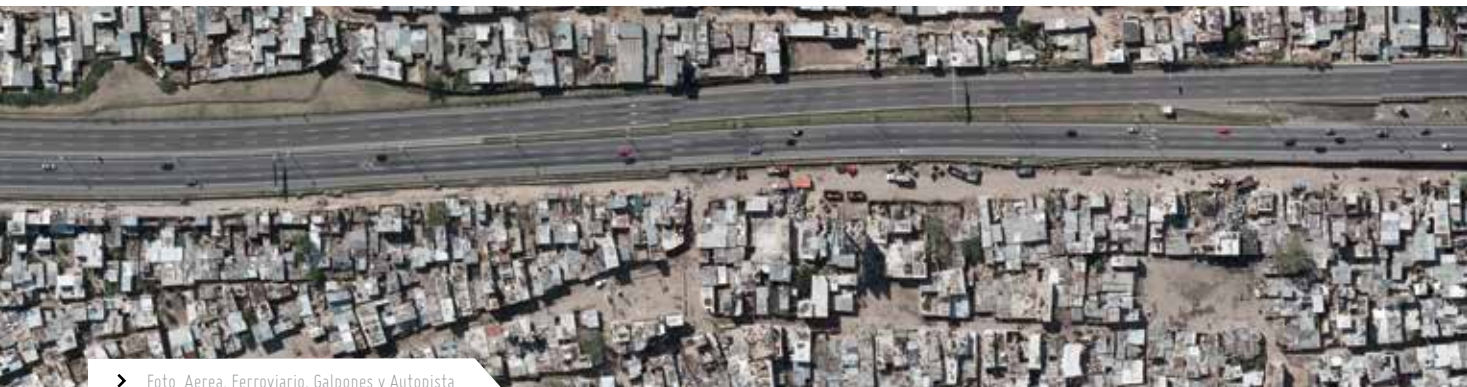
➤ Foto Aérea. Ferroviario, Galpones y Autopista
